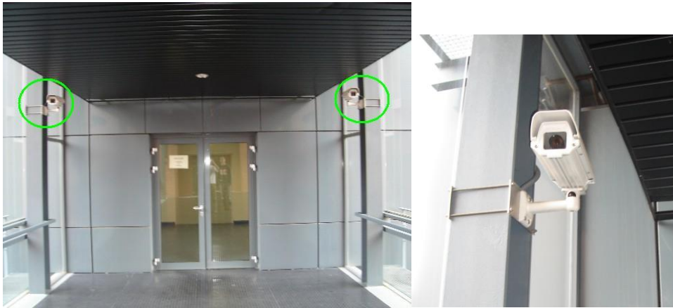
Figura 2. Situación de las cámaras fijas de la planta 3 (izda.) y detalle de una de las cámaras montadas (dcha.)
